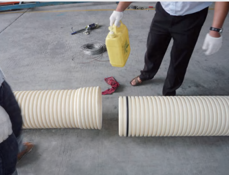
2、将橡胶密封圈安装在插口端第二与第三个波纹之产间的槽内。
