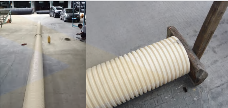
4、将插口端的中轴线与承口的中轴线对准，把插口插入承口。（一般来说：小口径管道用人力或在管端部设置木档板，用撬棍使被安装的管材沿其中轴线徐徐插入承口内；直至承口根部；大口径管道用麻绳和拉线器或手动葫芦将被安装的管材拉动到位）。
