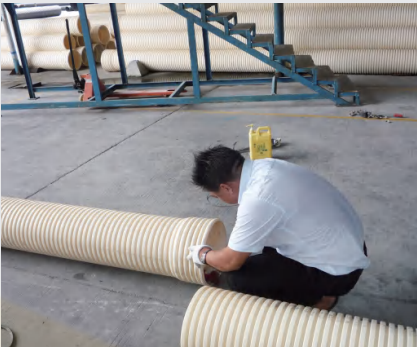
1、管道连接时，应先将承口内表面和插口外表面用棉纱清理干净，不得有泥沙等杂物。
